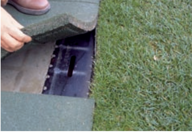
SPORTFIX slotted channel in the Estádio da Luz
